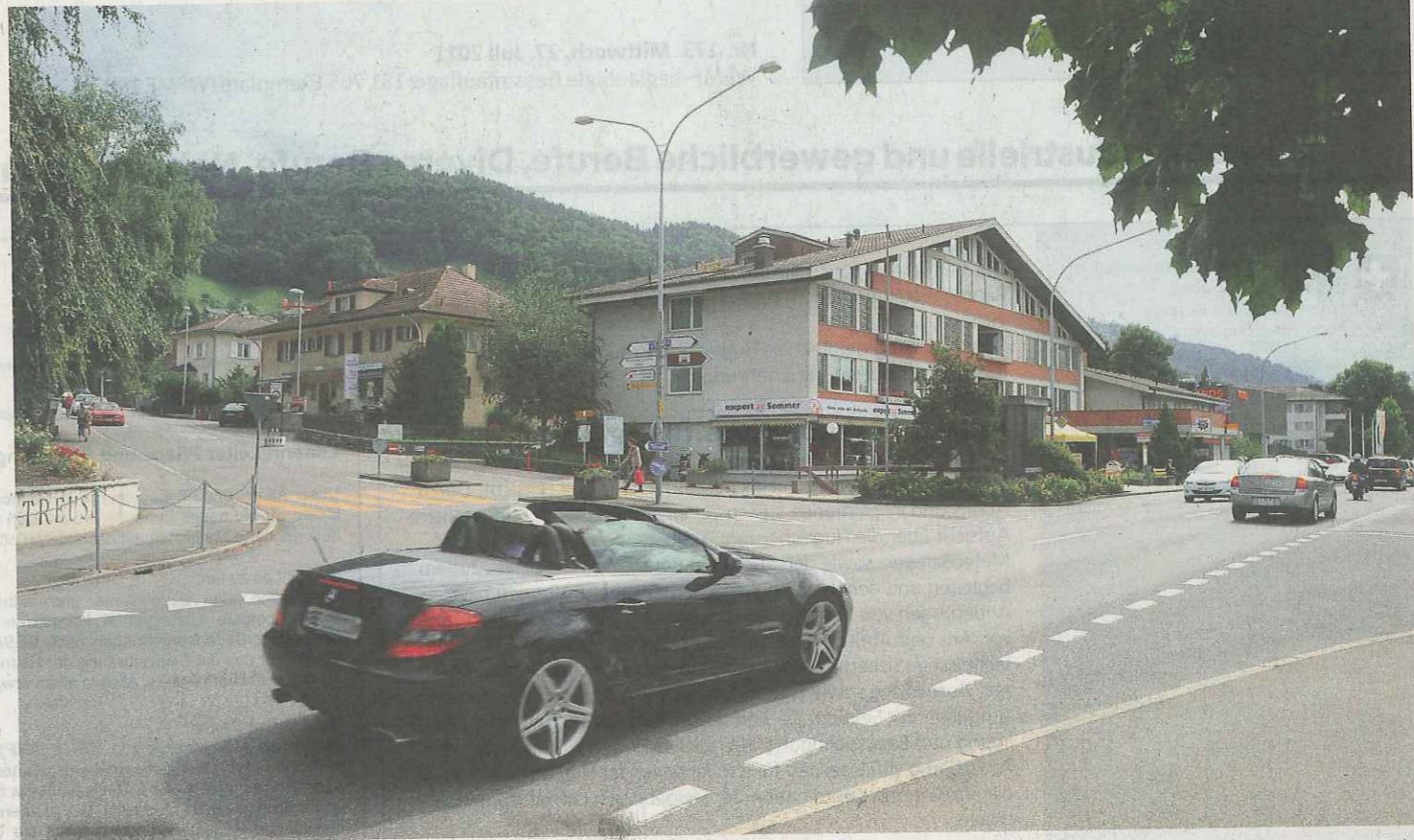
Viel befahrener Knotenpunkt: Die Chartreuse-Kreuzung in Hünibach soll umgestaltet und damit sicherer werden.
