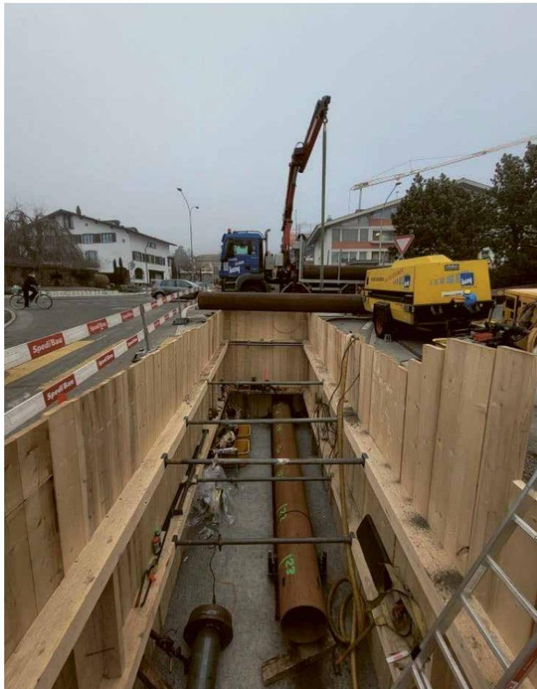
Bild: Startgrube für den Rammvortrieb der Stahlrohre.
