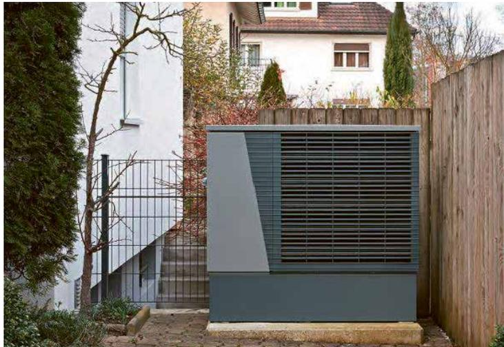
Frühere Modelle von Wärmepumpen können entweder 100 oder 0 Prozent Leistung erbringen. Diese schubähnlichen Schwankungen von Stillstand auf volle Kraft und umgekehrt erfordern unter anderem einen höheren Stromeinsatz. Richtig dimensionierte, leistungsgeregelte Wärmepumpen (Inverter-Technologie) werden heute zum Standard. Diese haben zwar längere Betriebszeiten, laufen dafür stets im optimalen Betriebspunkt, sind damit insgesamt effizienter und im Falle einer Luft/Wasser-Wärmepumpe auch leiser.
