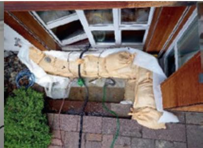
Schutzriegel mit Wasserpumpe
