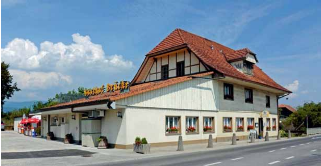
Der Gasthof Brücke in Hagneck
